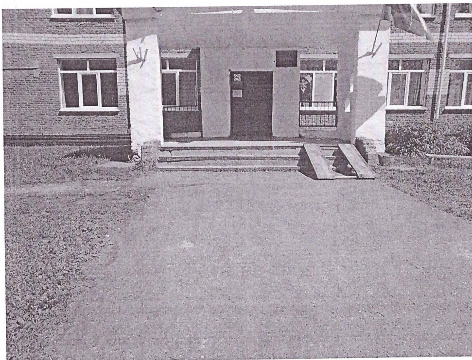
Фото №1-2 (Входная площадка)
