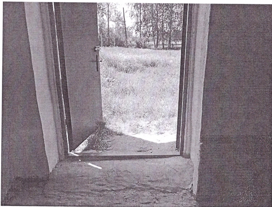
Фото №2-1 (Пути эвакуации)
